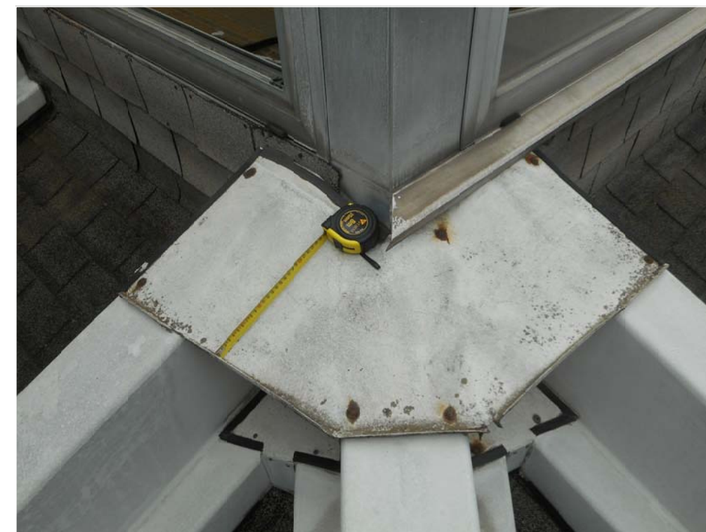
Encuentro de ménsulas con lucernario, tornillería oxidada.
