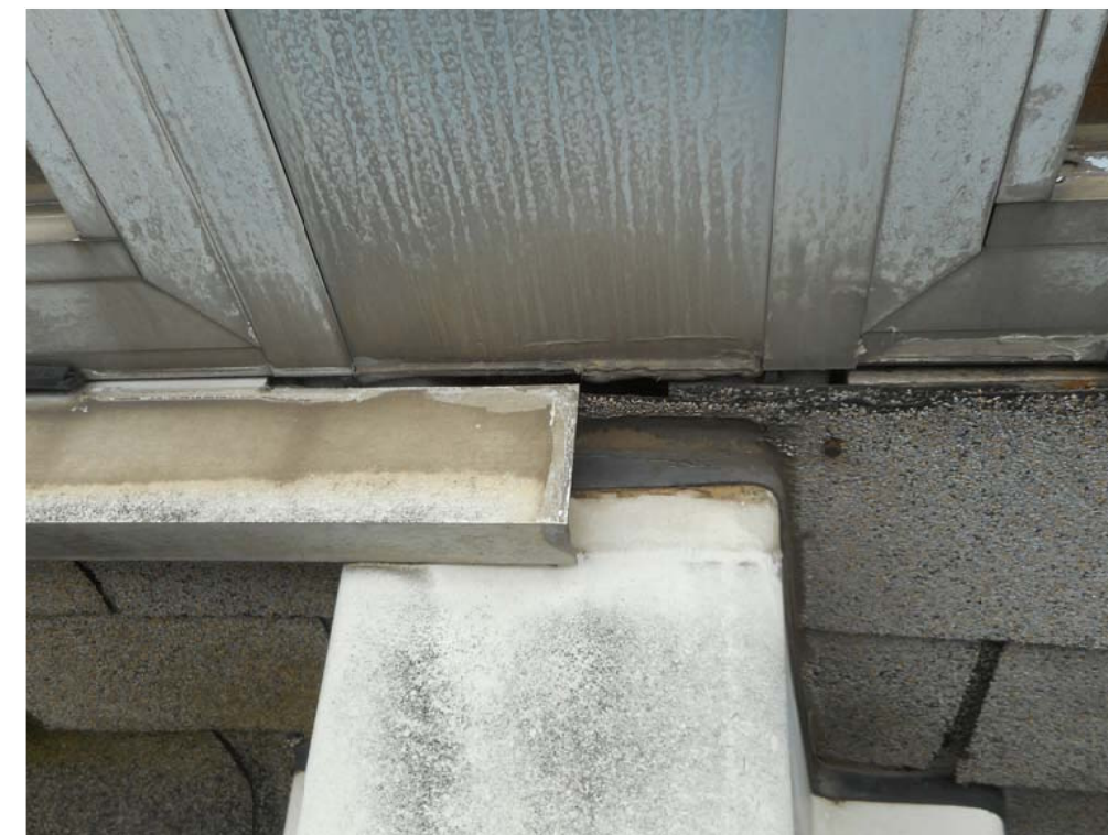
Degradación en encuentros, juntas y uniones entre distintos materiales.
