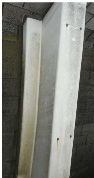
Tornillería oxidada en las coberturas de fibra y resina de las ménsulas.
