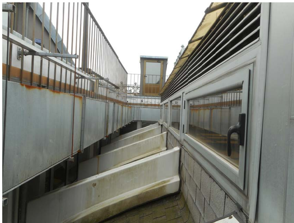
Ménsulas de apoyo del lucernario, vista lateral
